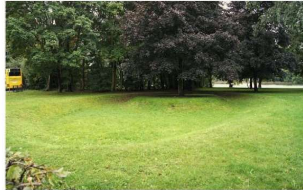
Figur 5-2 Nedsenkede områder i grønt-/parkområder tilrettelagt for kontrollert oversvømmelse. Til venstre fra Berlin og til høyre fra Växjö etter en regnhendelse (foto; Drammen kommune og Göran Lundgren).
