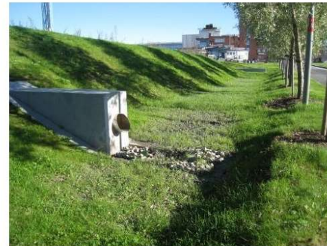
Figur 5-3 Eksempel på nedsenket grøntstruktur utformet for magasinering og infiltrasjon av overvann/flomvann fra et veianlegg, Fornebu (venstre foto). Gjennomgående grøntstruktur i bebyggelse utformet for overvannshåndtering og flom, Mariastaden i Helsingborg (høyre foto) (foto; COWI).
