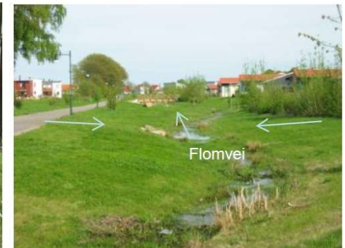
Figur 5-3 Eksempel på nedsenket grøntstruktur utformet for magasinering og infiltrasjon av overvann/flomvann fra et veianlegg, Fornebu (venstre foto). Gjennomgående grøntstruktur i bebyggelse utformet for overvannshåndtering og flom, Mariastaden i Helsingborg (høyre foto) (foto; COWI).
